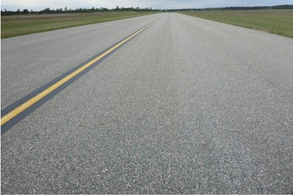
BJI PTA 002 (PCI = 85)
